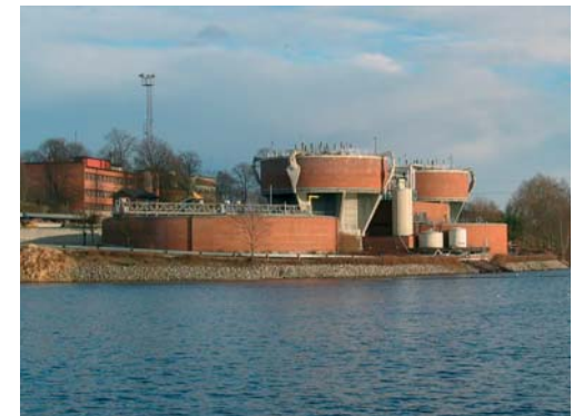
Det biologiske renseanlegget fra 1995.
