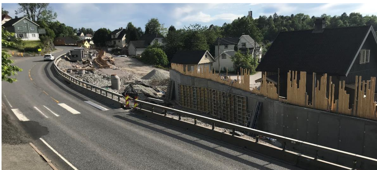
Bilde: 14 Fra Bakkedammen til Klevstrandkrysset bygges det nå sykkelveg med fortau. Ferdig i 2021.
