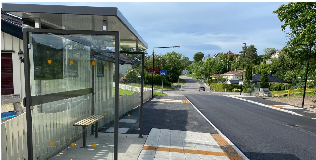
Bilde: 12 Busstoppet på toppen av Blåbærlia er rustet opp med universell utforming i begge retninger.
