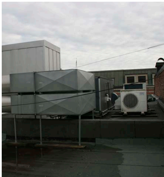
Eksisterende tekniske installasjoner, som kan dekkes med grønn vegetasjon
