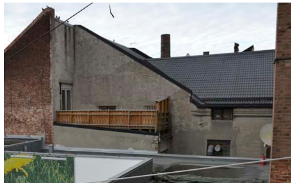
Eksisterende situasjon i det nordre hjørnet på taket
