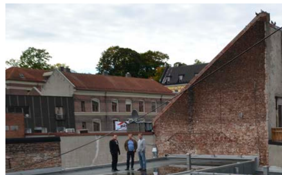
Eksisterende situasjon nord-vest på taket
