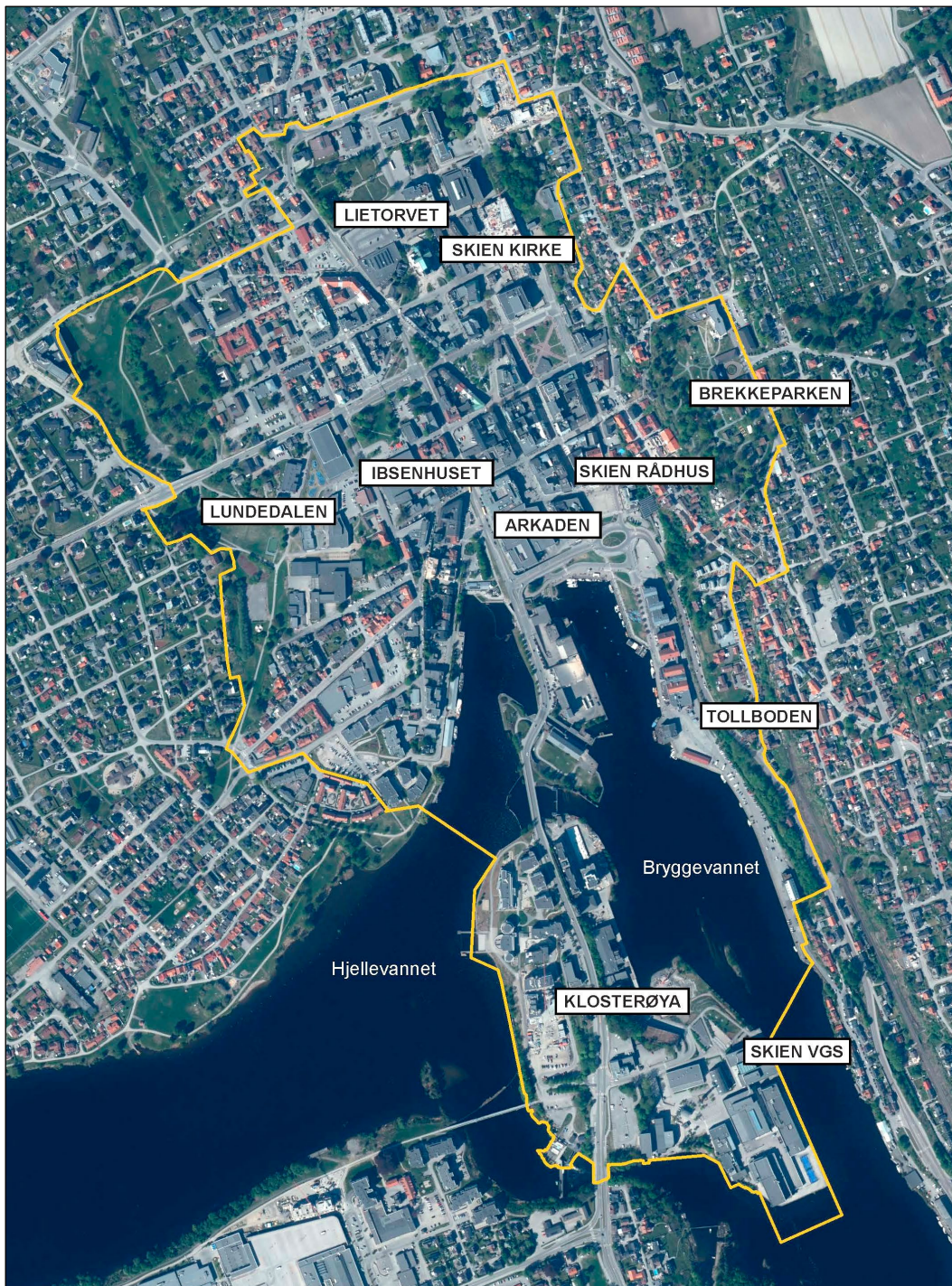
Figur 3-1: Planområdet strekker seg fra Schweigaards gate i nord, langs Lundedalen i vest og Brekkeparken i øst, til sørenden av Klosterøya.
