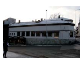
19. Kverndalsgata 4a, bygg 2
