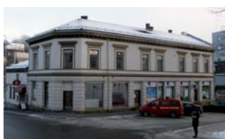
18. Kverndalsgata 4a, bygg 1
